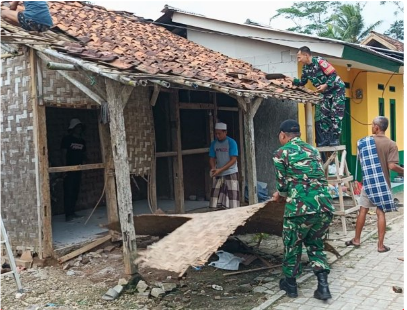
Pembongkaran Rumah Bapak Narmin
